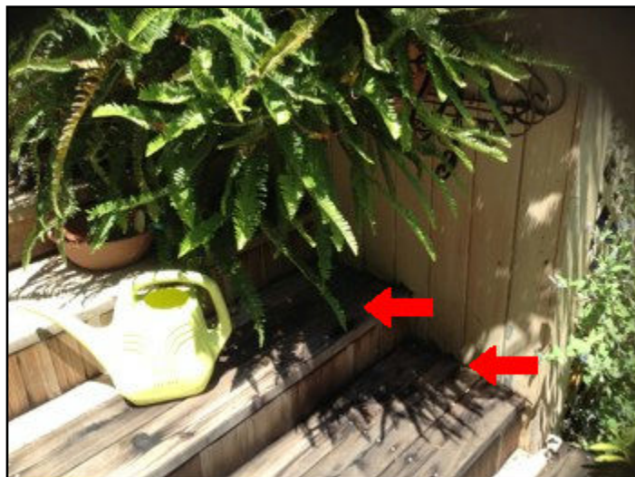
26. Moisture damage
