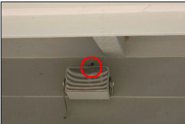
29. Pest intrusion point
