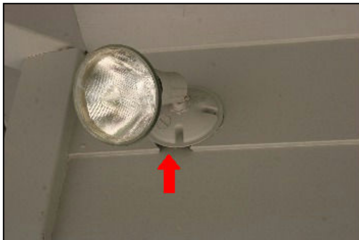
30. Pest intrusion point
